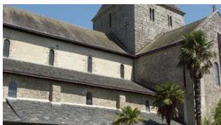
Entre Novembre 2019 et Mars 2021, d'importants travaux ont été réalisés sur l'église. Changements complets des charpentes et couvertures des deux bas cotés et d'une partie du chœur, mise en place de nouvelles gouttières facilitant la circulation des eaux pluviales.
